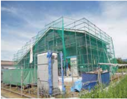
建設中の住宅
