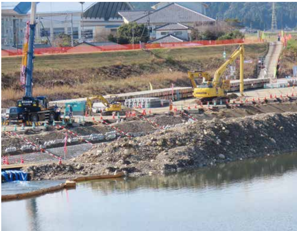
小丸川の河道掘削工事
