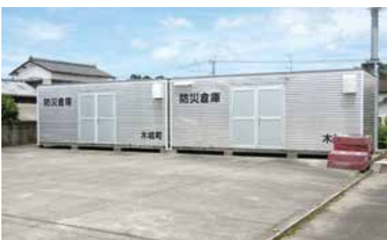
備蓄倉庫 (高城町地区)
