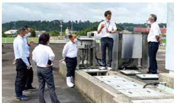
現地調査の様子(木城浄化センター)
