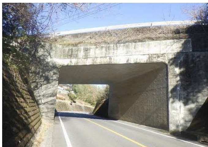
図 10 道路を跨ぐ施設の例（木城町管理 溜水ボックスカルバート）
