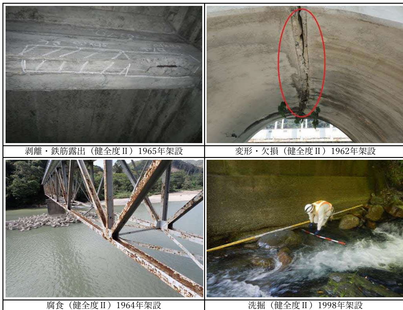
図 6 損傷状況
