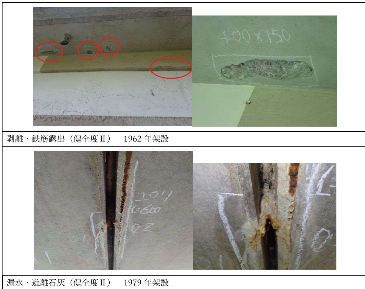
図5 損傷状況
