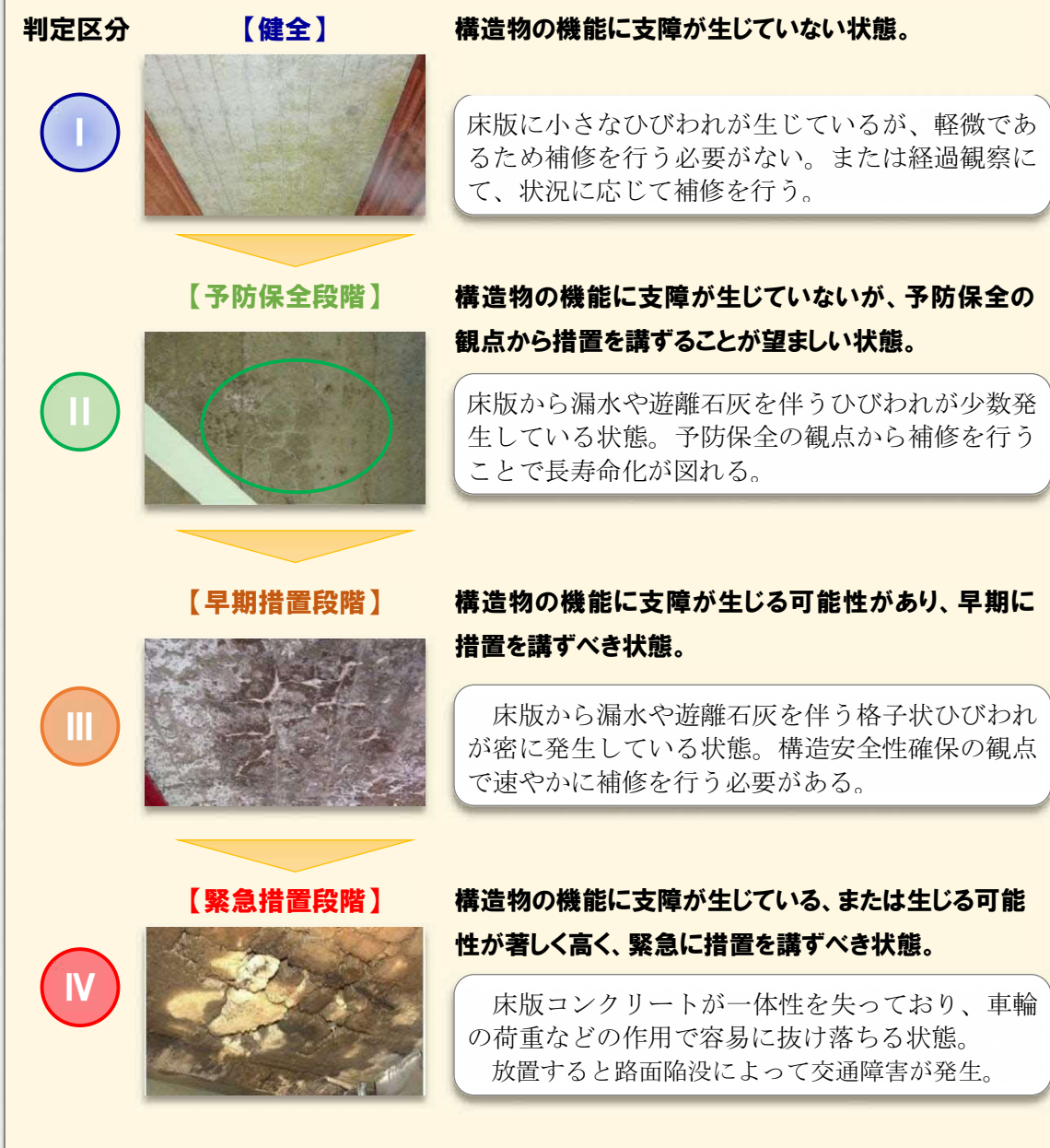
図 13 橋の健全度の事例
