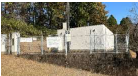
【中央地区第 2 配水池 全景】
