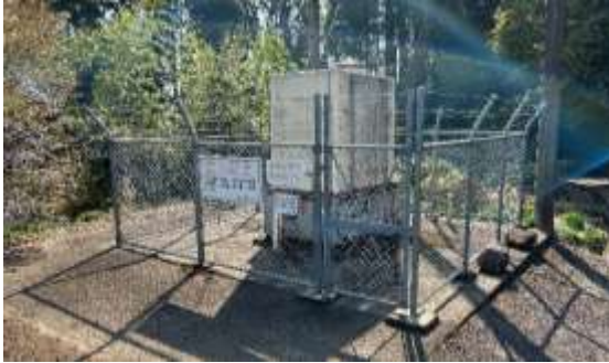
【中央地区仁君谷地区加圧ポンプ場 全景】
