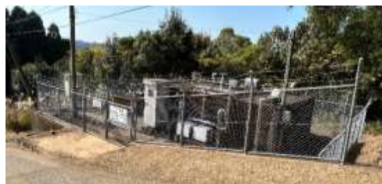
【川原地区高地区配水池 全景】
