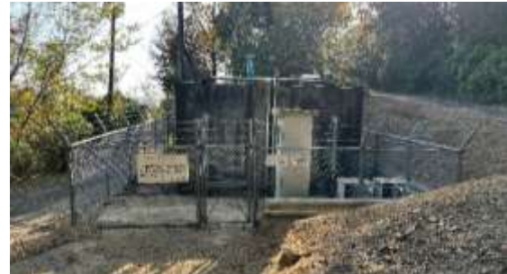
【中央地区第 3 配水池 全景】
