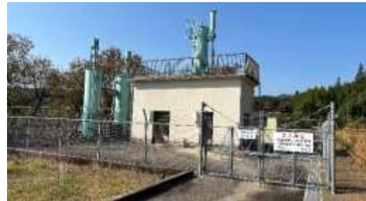
【川原地区低地区浄・配水場 全景】
