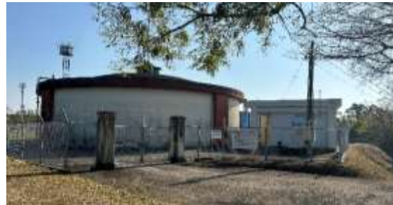
【中央地区浄水場・第 1 配水池 全景】
