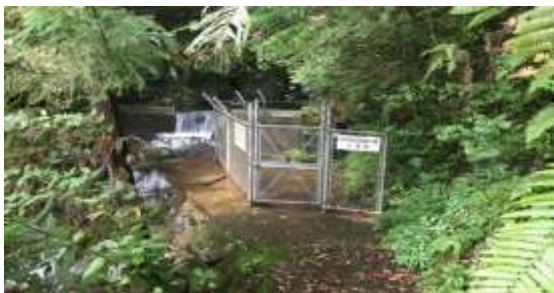
【石河内地区水源地 全景】
