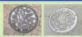
木城町マンホール
